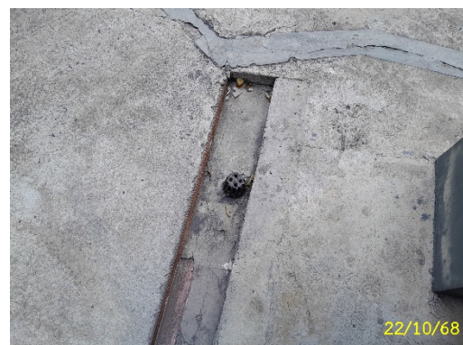
ภาพที่ 2.2-18 ตะแกรงครอบบรูท่อน้ำ
