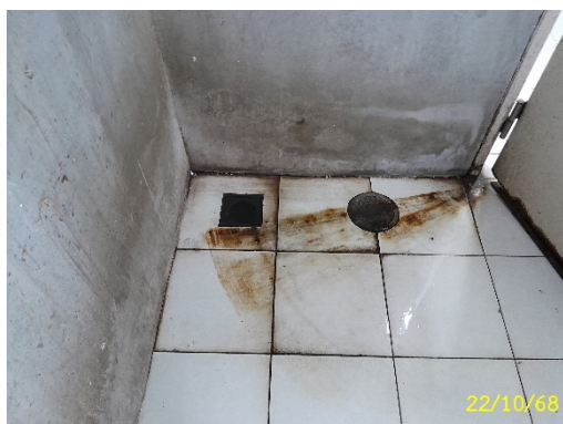
ภาพที่ 2.2-18 ตะแกรงครอบบรูท่อน้ำ
