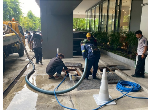
สูบน้ำตะกอน และตักไขมัน
