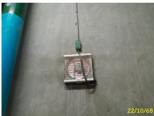
พัดลมระบายอากาศห้องพักขยะรวมเปียก
