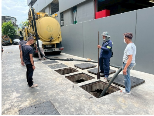
สูบน้ำตะกอน และตักไขมัน
