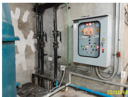
บ่อรับน้ำฝนชั้นใต้ดิน และตู้ควบคุม
